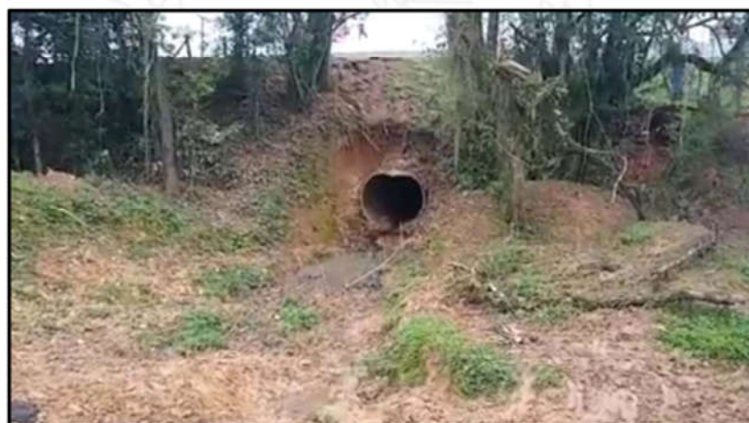
Figura 03 – Imagem do ponto "B", que mostra ausência de fluxo de água na saída da tubulação de drenagem pluvial (trecho em amarelo)
