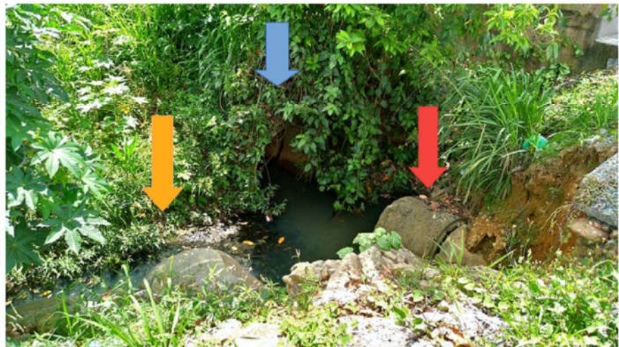
Foto 05: Vista da tubulação de grande porte que vem da montante (seta azul), tubulação antiga (seta vermelha) e tubulação nova (seta laranja). As tubulações indicadas pelas setas vermelha e laranja conduzem as águas para a desembocadura.
