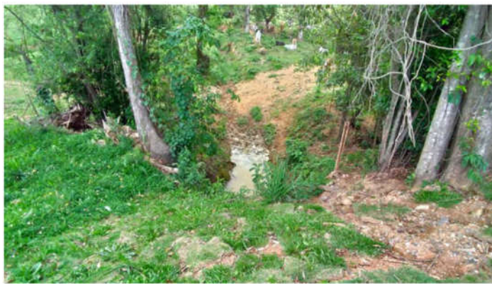
Foto 06: Vista da desembocadura das águas tubuladas. Notar a presença de bovinos na parte superior da foto.
