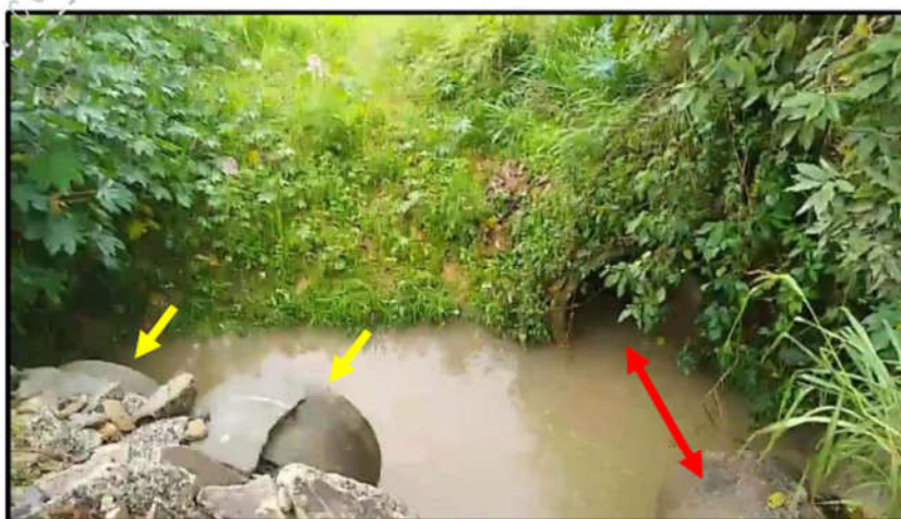
Figura 02 – Imagem do ponto "A", que mostra o desnível entre as tubulações: à esquerda os tubos implantados pelo município (entrada do trecho amarelo); à direita a tubulação por onde passa o corpo hídrico (entrada do trecho em vermelho).
